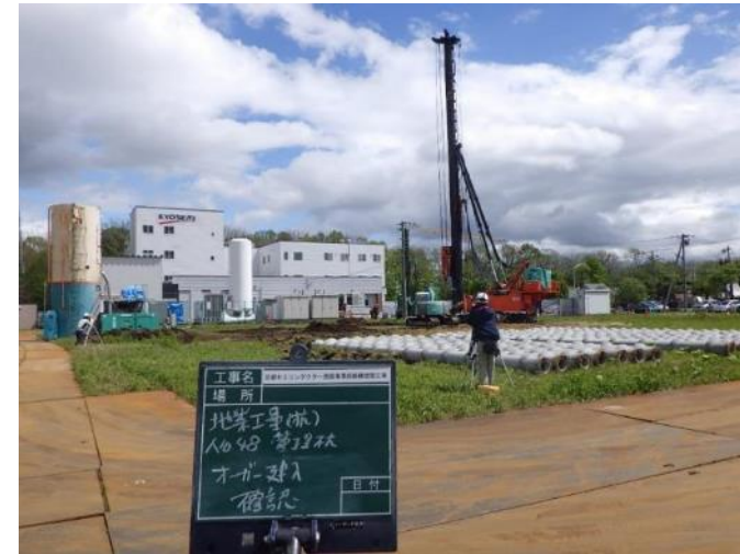
杭打ち工事開始
