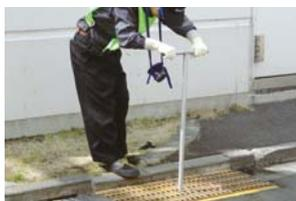
②緊急遮断弁を閉じる
