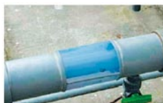
薬液配管の二重化
